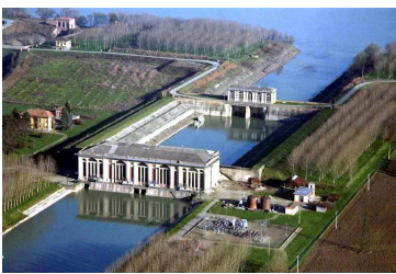
impianto idrovoro delle Pilastresi
